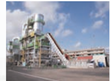
宮城県気仙沼ブロック(階上地区)の仮設焼却炉
